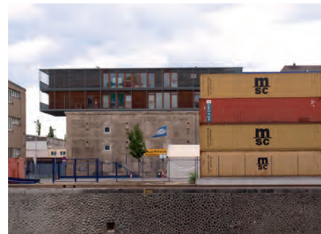
Bunkeraufstockung, Index Architekten
